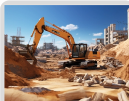
Canteiros de obras
