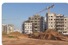
Canteiro de Obras
